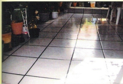
Mejoras en vivienda por entrada de humedad de agua pluviales En Cabecera Municipal.
