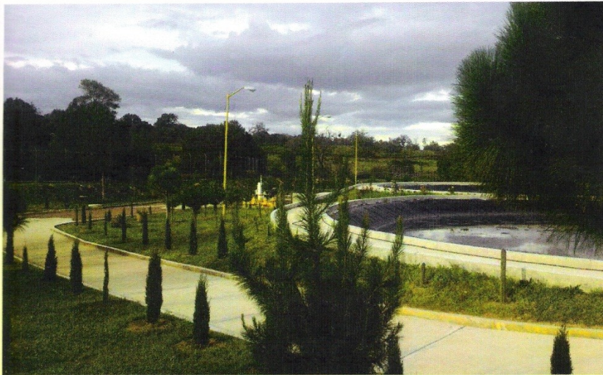
PLANTA TRATADORA DE AGUAS NEGRAS MONTE ESCOBEDO, ZAC.
