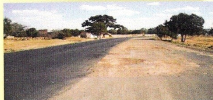
Reparación de baches en Carretera Monte Escobedo Mezquitic, Jal.
